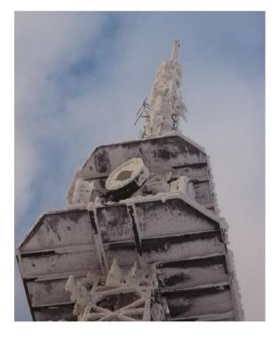
L'accumulo di ghiaccio sulle antenne è spesso causa di interruzione del servizio nel settore delle telecomunicazioni.
